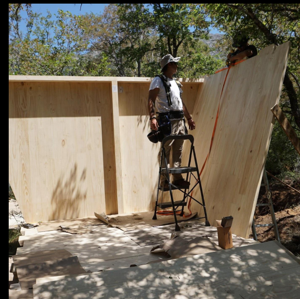
INSTALACIÓN EN 1 MES
